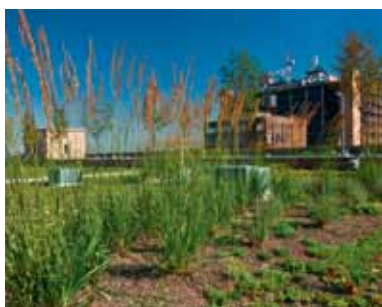
Das begrünte Dach der United States Postal Service in New York.
