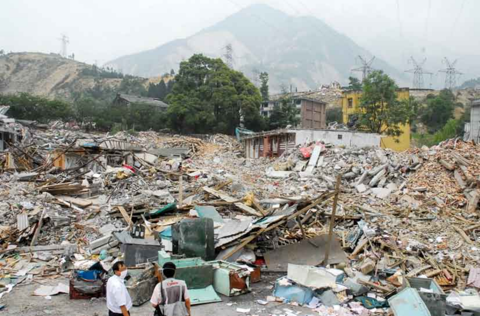
..... Zerstörte Poststelle in Yingxiu
